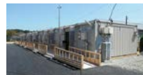
山口県応急仮設住宅
