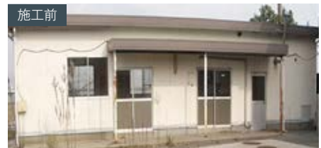
外壁塗装工事 間取変更工事
