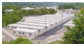
弊社仙台工場敷地内仮設住宅
