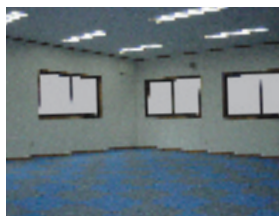
10 内装仕上がり
