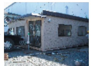
7 2棟目と3棟目の連結作業
