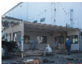
5 1棟目と2棟目の連結作業
