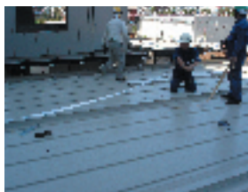
8 連結部の雨水養生施工
