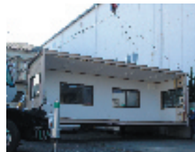
3 1棟目吊り降ろし
