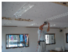
9 連結部の内装施工
