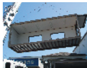
6 3棟目吊り降ろし
