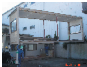
4 2棟目吊り降ろし
